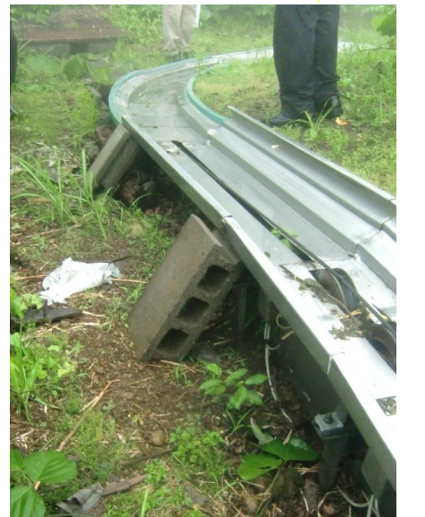
コースレールをブロックで応急処置的に支えている状態の施設も
