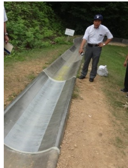
コースの一部の入れ替え工事が行われた金谷山コース
