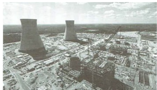
東芝傘下のウエスチングハウス社が米国内で建設中の原発
