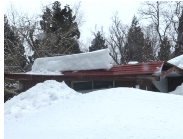
屋根が大きく破損した一般住宅。支援の手が緊急に必要です。(安塚区)
