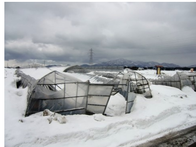
どか雪前には周囲を完全に除雪しておいたのに、記録的な降雪でハウスが倒壊。(大潟区)
