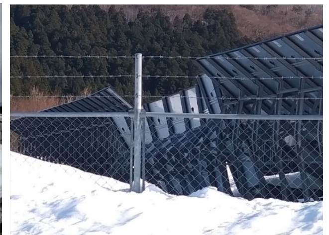
大規模太陽光発電施設も倒壊。(谷浜公園)
