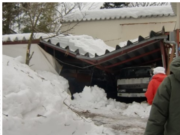
農機具格納庫が倒壊。入れてあった新品の田植機、コンバイン、トラックが破損。(浦川原区)
