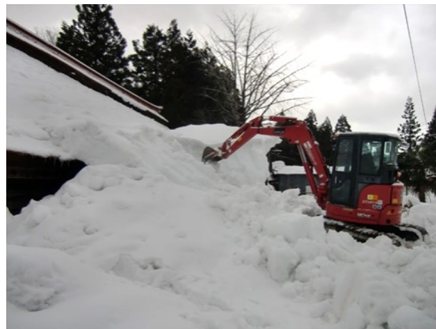
屋根雪と地面の雪がつながってしまう4メートル超の積雪。重機なしには除雪不能。(中ノ俣)
