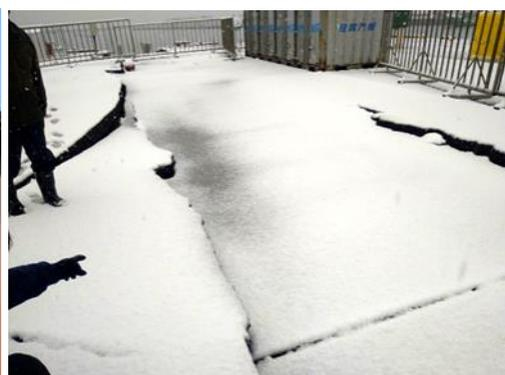
佐渡汽船埠頭付近では、地面の不等沈下で大きな段差が生じています。
