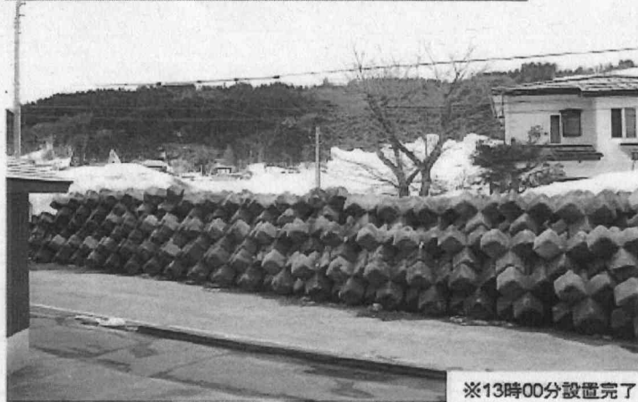
※13時00分設置完了
