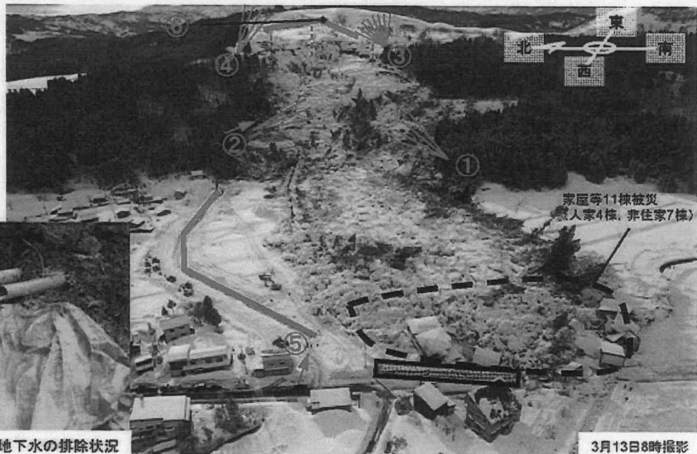
地下水の排除状況
