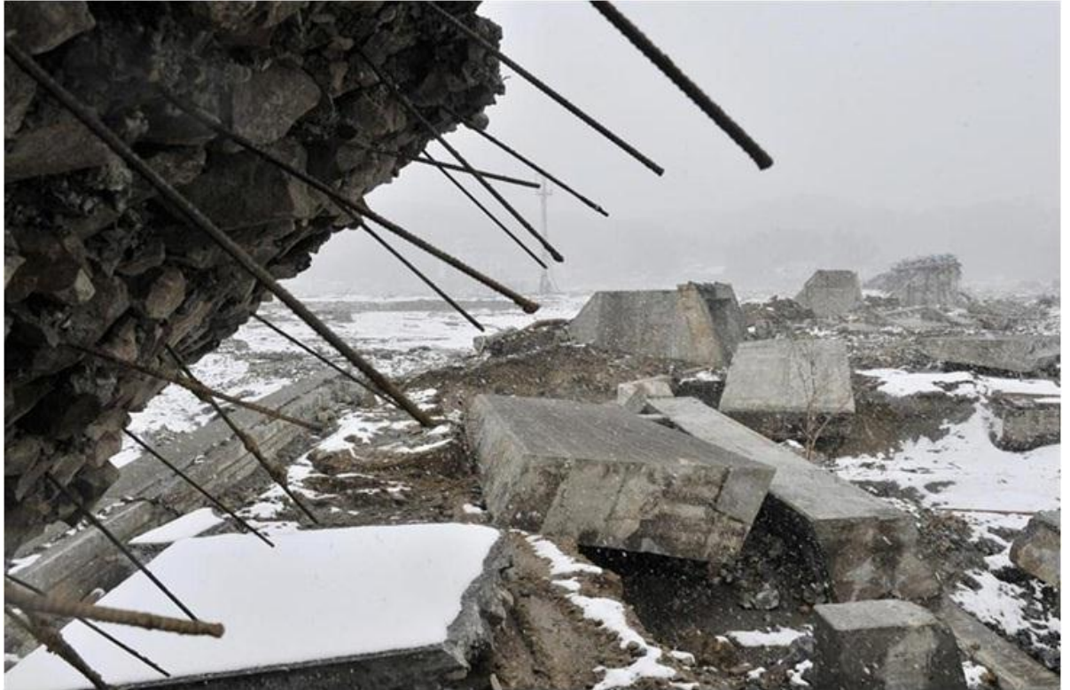
2011年3月11日東日本大震災に伴う津波で倒壊した防潮堤(岩手県宮古市田老地区)
