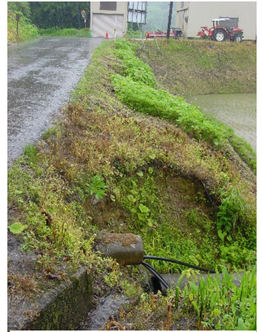
路肩が崩れ排水口がむき出しに。下川谷地内の県道。
