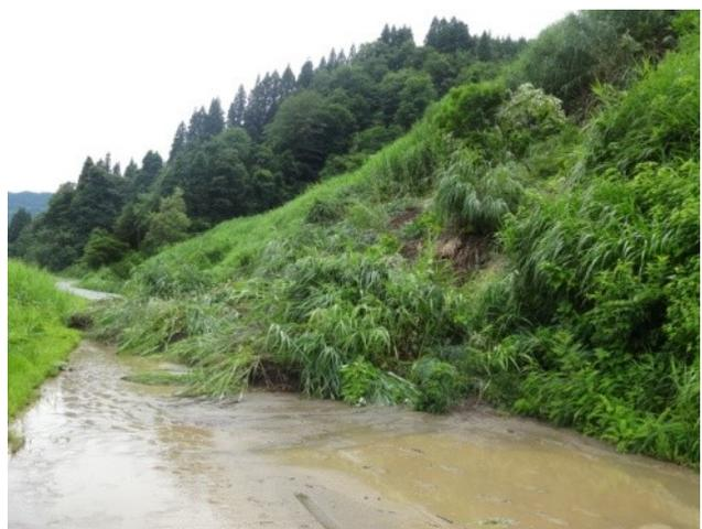
台風8号による被害は上越市内にも出ています。被害の多くは道路関係で、土砂崩れや道路への土砂流失です。被害の最も多かったのは大島区で、道路関係だけで8件にもなっています。写真（橋爪が撮影）は大島区大島地内の市道道田線です。土砂崩れのため10日現在交通止めとなっています。
