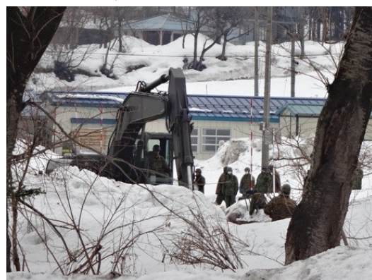
油漏れの処理作業中の自衛隊（当時）
