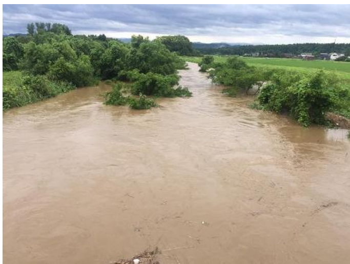
3日6時43分。柿崎区上原橋下流。雑木除去が必要。
