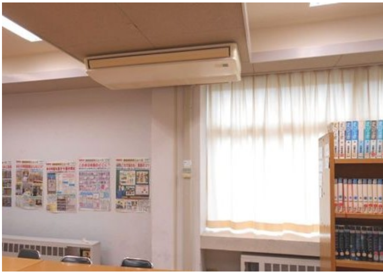
吉川中学校図書室に設置されているエアコン。写真は市役所提供。
