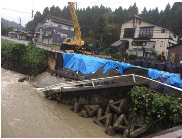
板倉区別所の県道崩落現場（14日）
