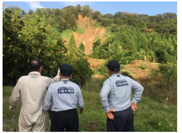
名立区東蒲生田の地滑り現場（13日）
