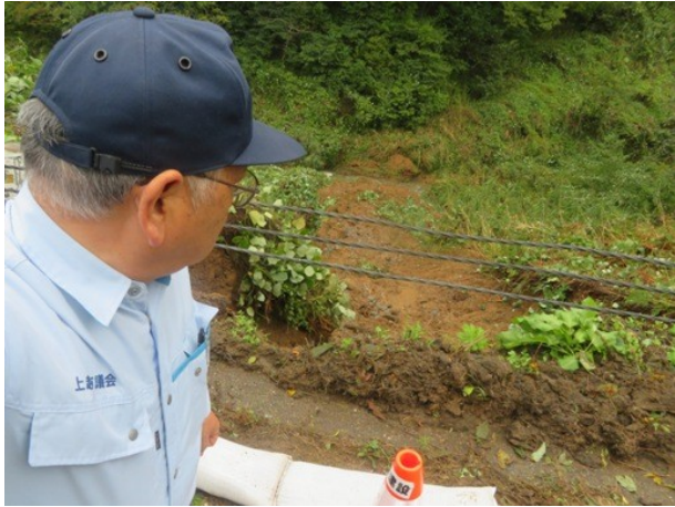
吉川区川谷の県道路肩崩落現場（13日）
