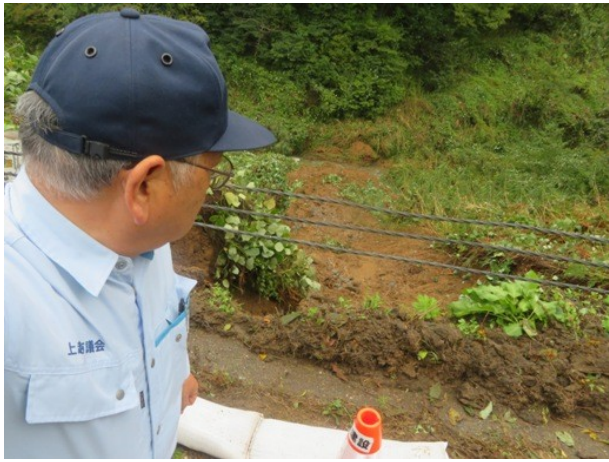
吉川区川谷の県道路肩崩落現場（13日）
