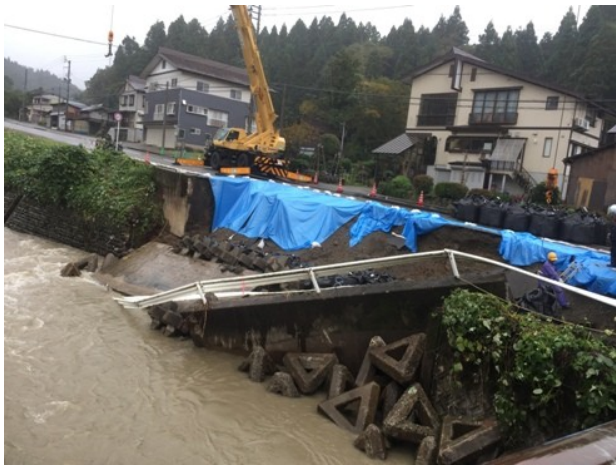
板倉区別所の県道崩落現場（14日）
